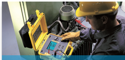
Messung & Prüfung der elektrischen Sicherheit
