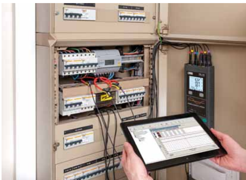
PEL 103: installiert im Schaltschrank, kommuniziert mit Android-Smartphones oder -Tablets
