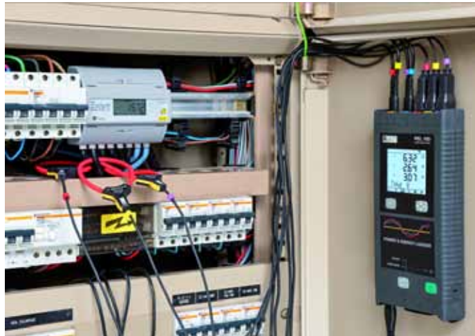
PEL 103: Installationsbeispiel im Schaltschrank
