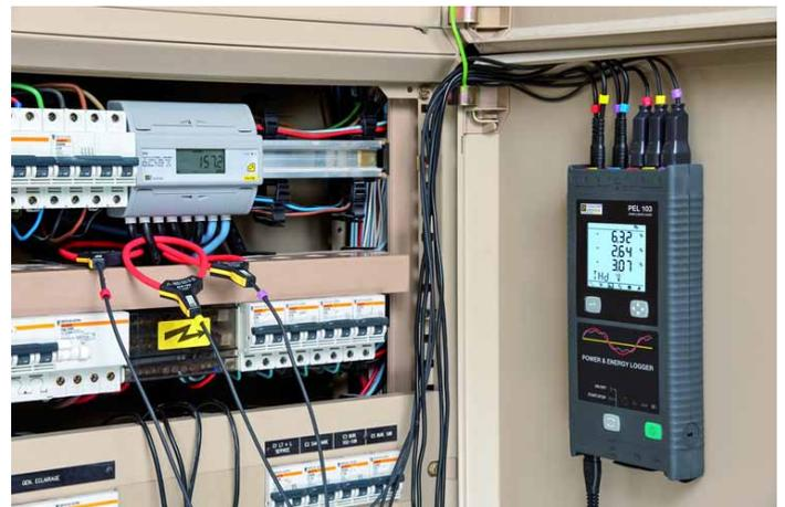
Power & Energy Logger PEL 103: Installationsbeispiel im Schaltschrank
