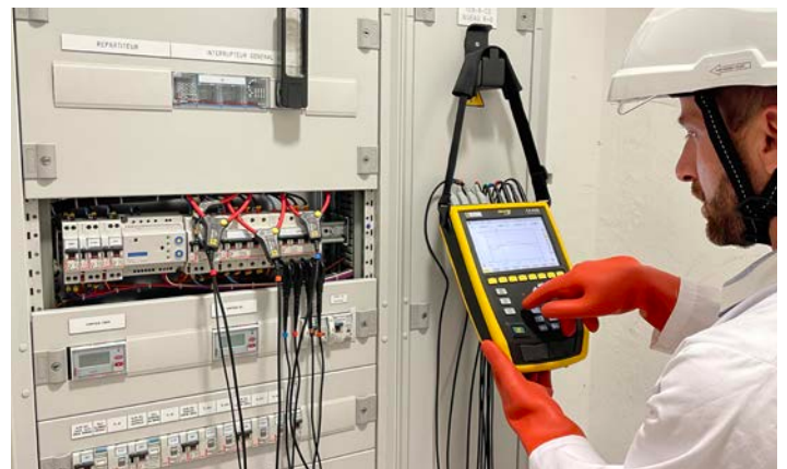
Leistungs- und Netzqualitätsanalysator, Qualistar Klasse A, CA 8345
