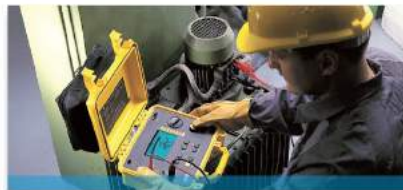
Messung & Prüfung der elektrischen Sicherheit
