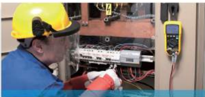
Messung bei Niederspannung
