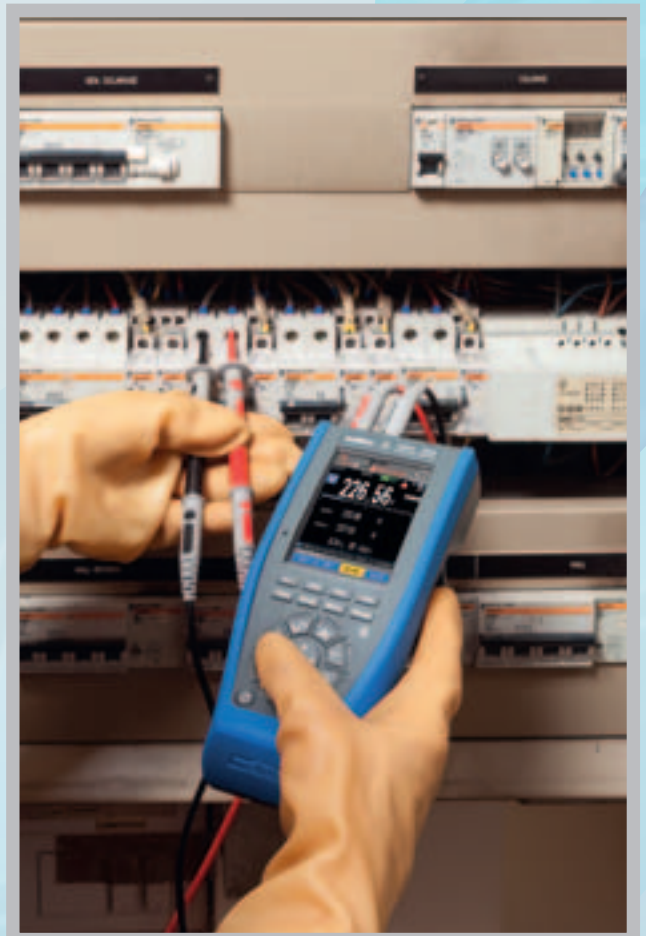
Messungen an elektrischen Schaltschränken
